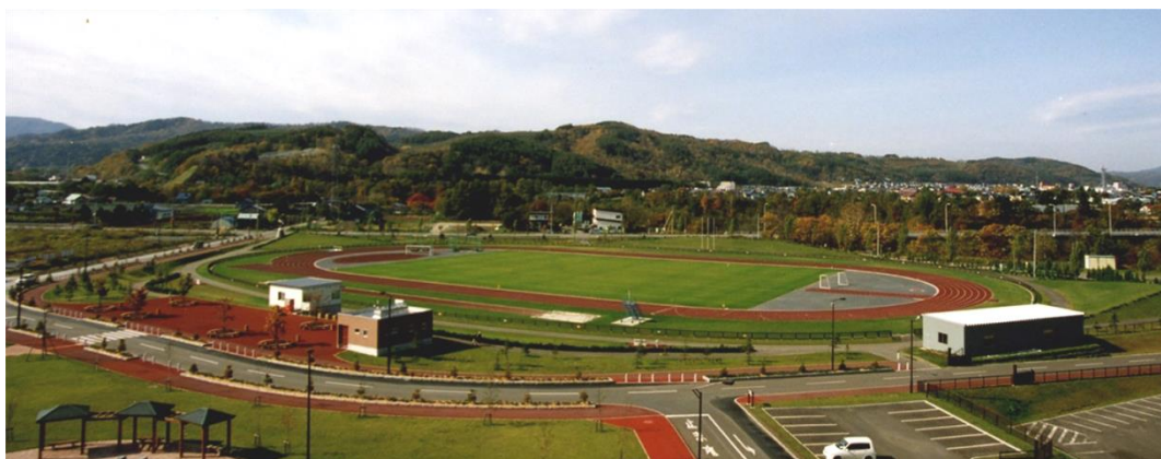
陸上競技場全景
