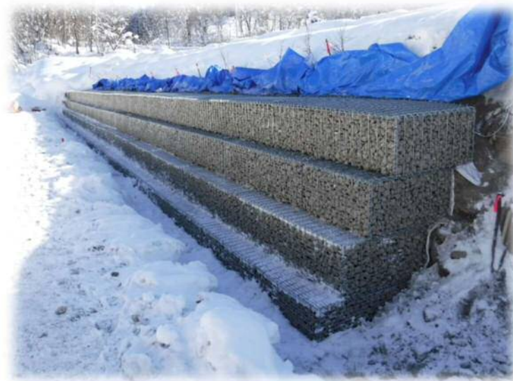
[河岸改修工事の状況]
