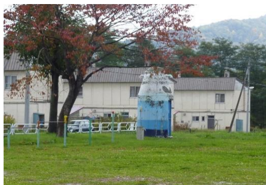
老朽化が進む公園の状況
