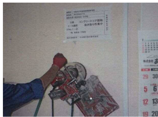
コンクリート強度検査コア採取
