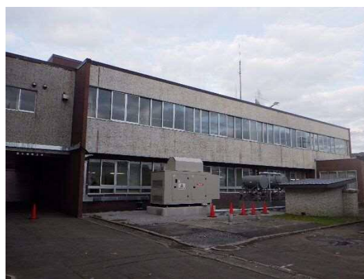
旧消防・議会棟（南面）
