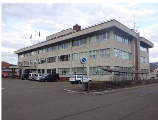
本庁舎（正面・南面）
