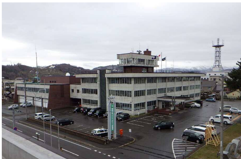
現在の耐震化が必要な総合庁舎と旧消防庁舎
