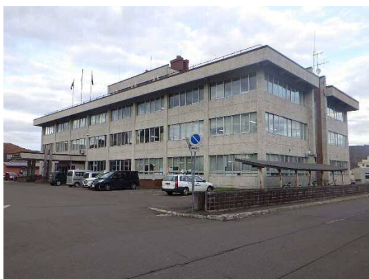
本庁舎（正面・南面）
