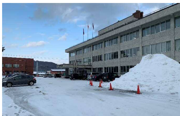
堆雪により駐車スペースが狭くなる一般駐車場
