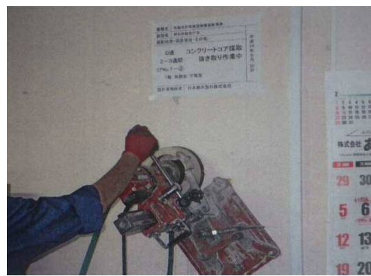
コンクリート強度検査コア採取
