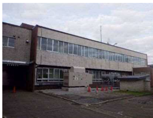
旧消防・議会棟（南面）
