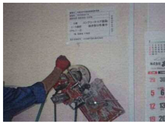
コンクリート強度検査コア採取
