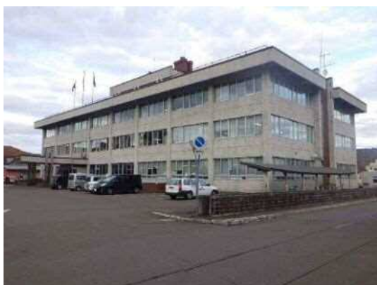
本庁舎（正面・南面）
