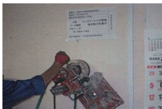
コンクリート強度検査コア採取
