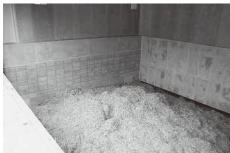
健民センター施設群に導入した木質チップボイラーのチップサイロ
