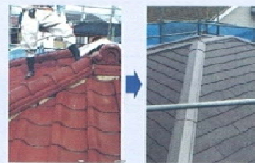
軽い屋根材への葺き替え
