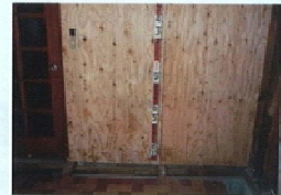
外壁側から筋かいや構造用合板により補強(外壁仕上工事費を含む)
