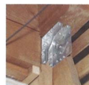
接合部の補強 2 (柱と梁の接合部の補強)
