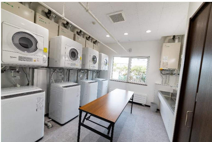
洗濯・洗面室
