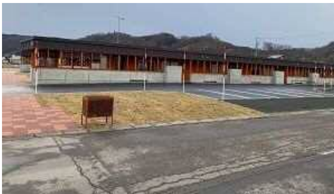
公営住宅（すみれ団地）
