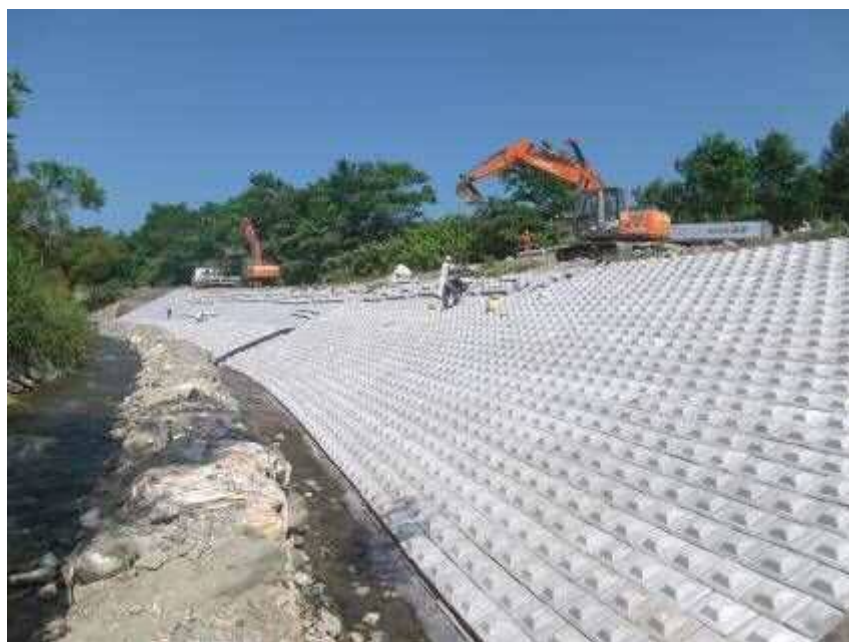
治水対策（河川改修工事）
